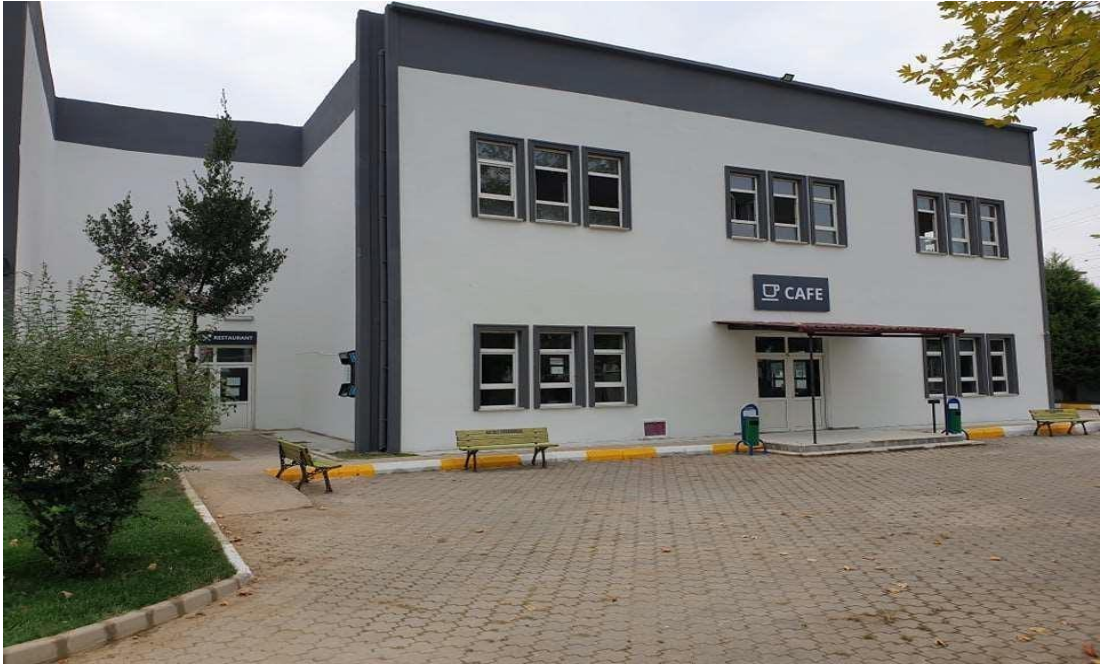
Yemekhane ve Kantin Binası
