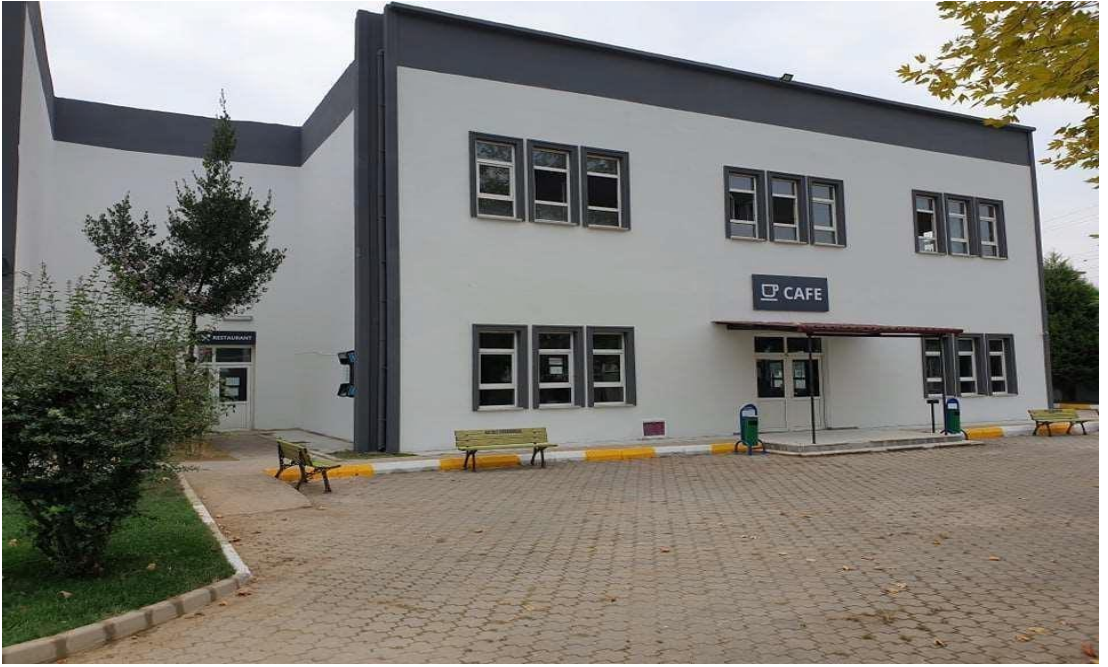
Yemekhane ve Kantin Binası
