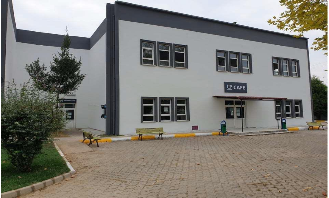
Yemekhane ve Kantin Binası
